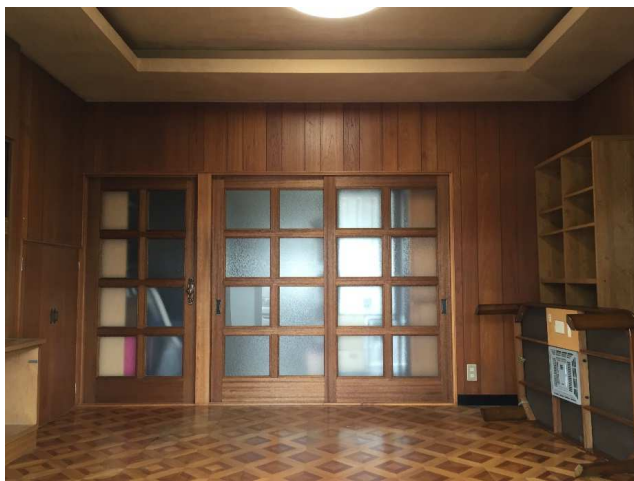
床・天井を解体してシェルターを設置しました
