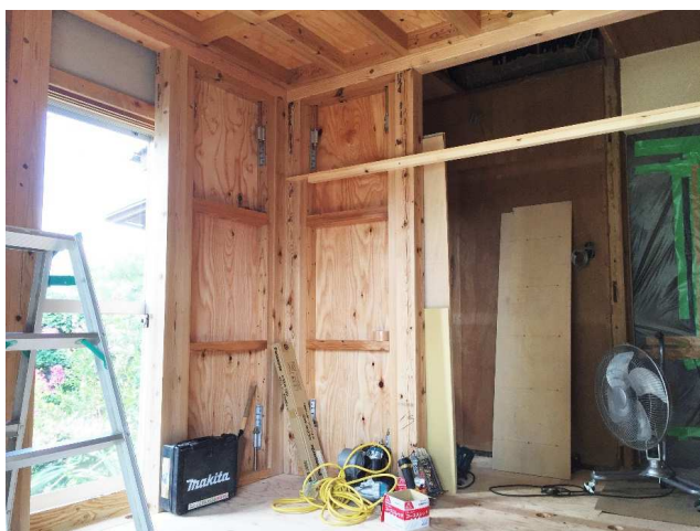
強固なシェルター躯体を設置します
