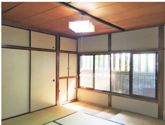
入母屋の住宅内部に耐震シェルターを設置
