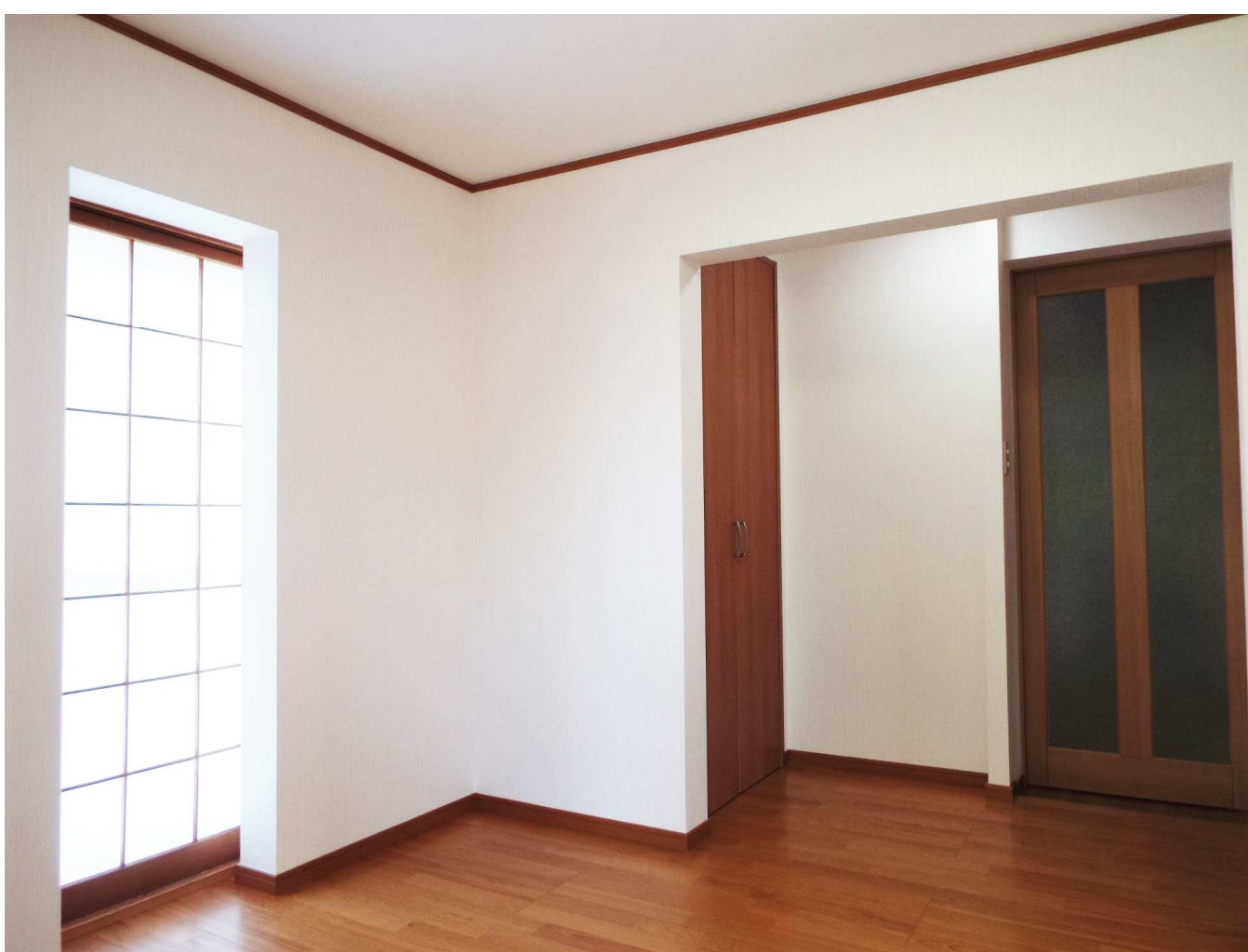
明るく開放感のある耐震シェルターを設置することが出来ました
