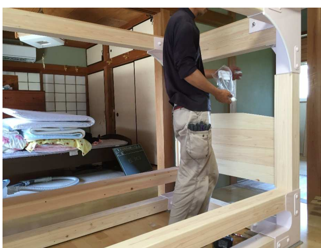
耐震ベッドは1日で設置が可能です
