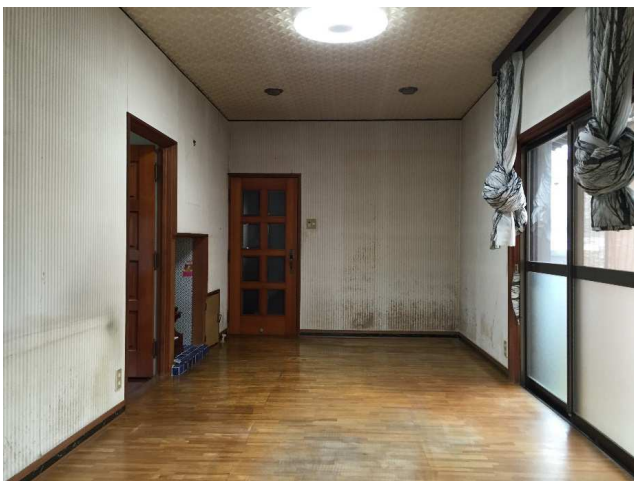
耐震性能が低いため、居間にシェルターを設置
